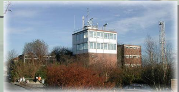
Hauptgebäude in der Weserstraße
